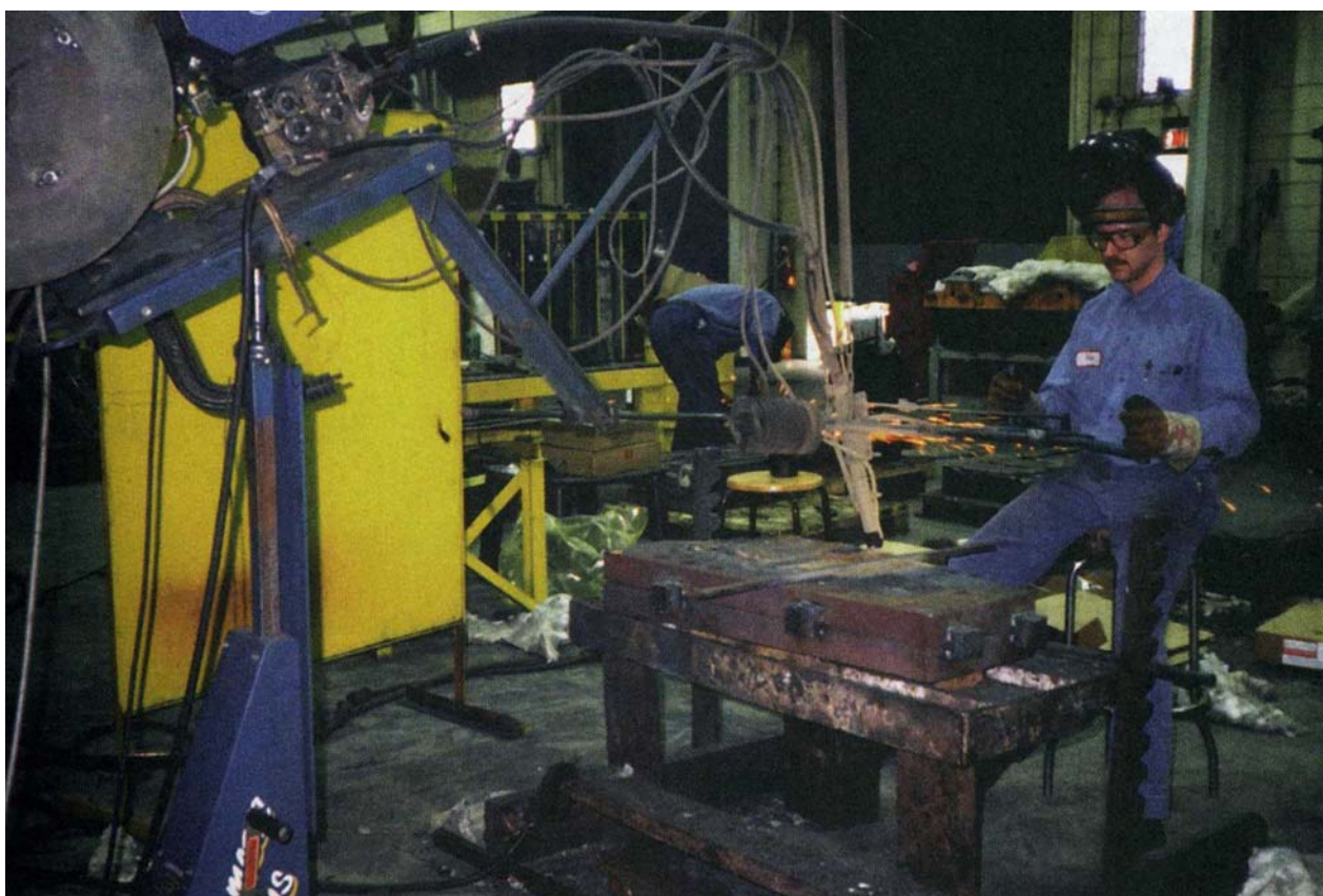
圖 4.15 — 用洪焊修理模具的操縱設備
